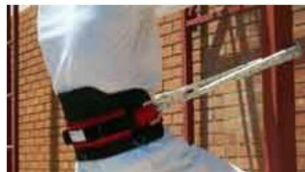
**Recuerda:** Para minimizar la caída libre, es importante, seleccionar un punto de anclaje estructural que se encuentre por encima del punto de conexión al arnés.
